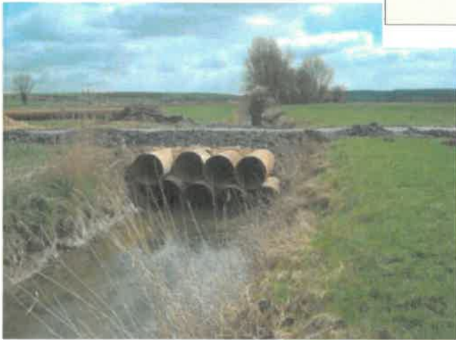
Figure 36 – Plan de principe d'un busage provisoire
